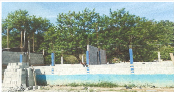
Foto 3: Suministro e instalación de paredes de Block
