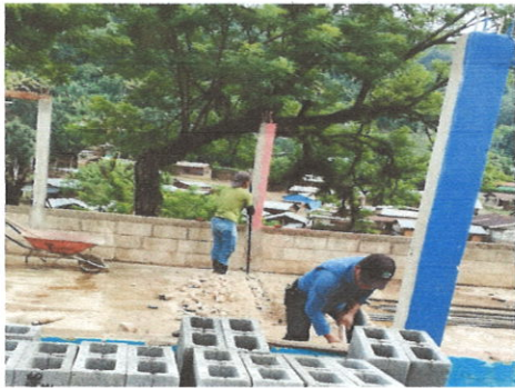
Foto 4: Suministro e instalación de Cimiento corrido
