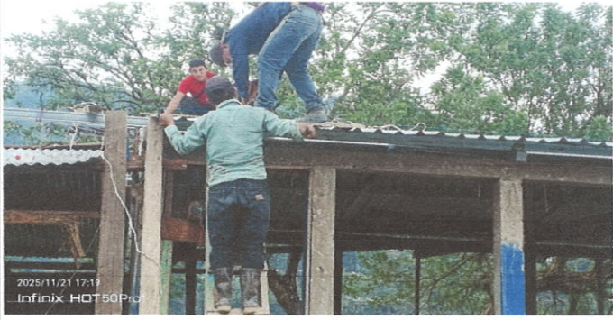
Foto 2: Suministro e instalación de techo con lamina troquelada
