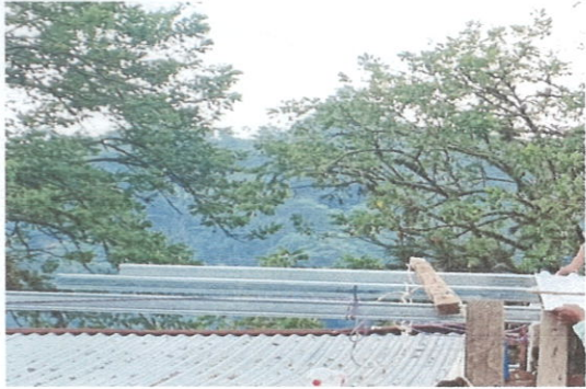
Foto1: Suministro e Instalación de estructura metalica tipo portico
