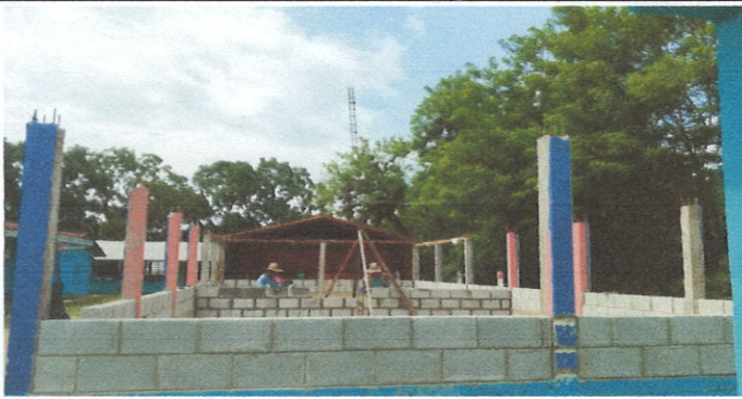
Foto1: Suministro e Instalación de columnas de concreto
